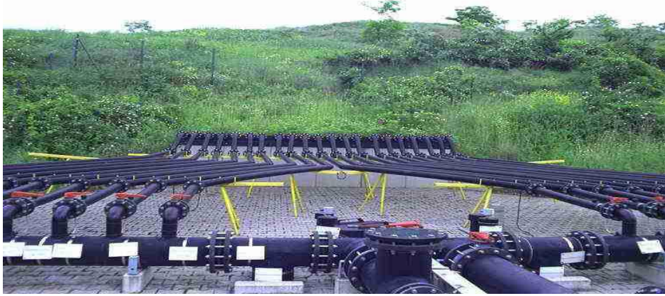
الصورة ( 1 ) نموذج لتجميع أنابيب الغاز الأفقية في المطمر (المرجع رقم 10 )
