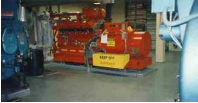
الصورة (3) نموذج لمجموعة توليد الكهرباء من غاز الميثان في محطة لمعالجة الصرف الصحي
