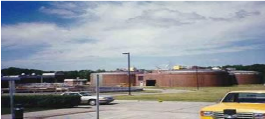
الصورة رقم (2) تبين نموذج لخزانات الهضم اللاهوائي في محطة معالجة الصرف الصحي (المرجع رقم 9)
